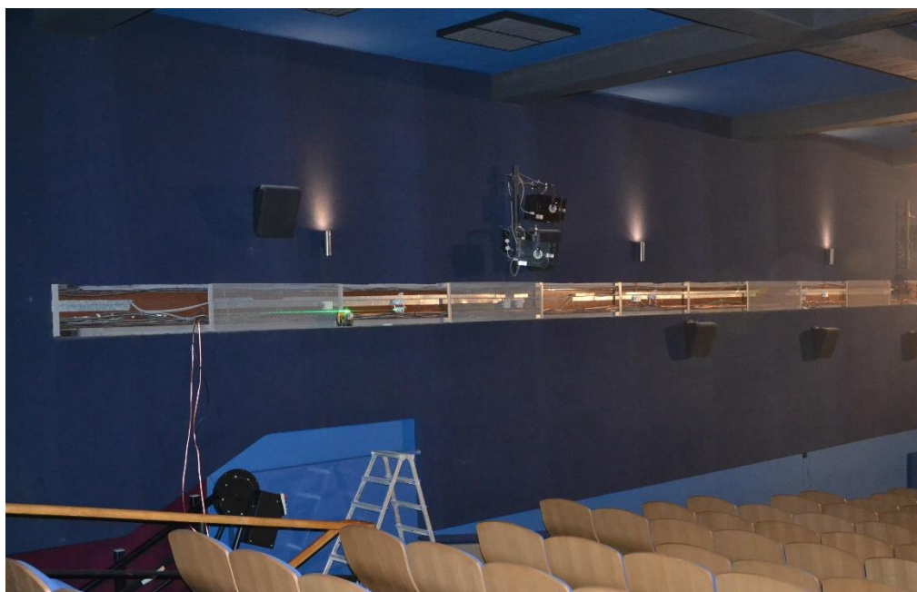
Výměna osvětlení v Kině Svratka
